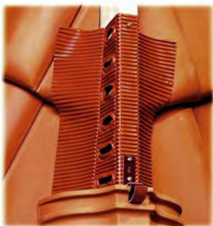
Abb. 7.4. Trockengratverlegung
